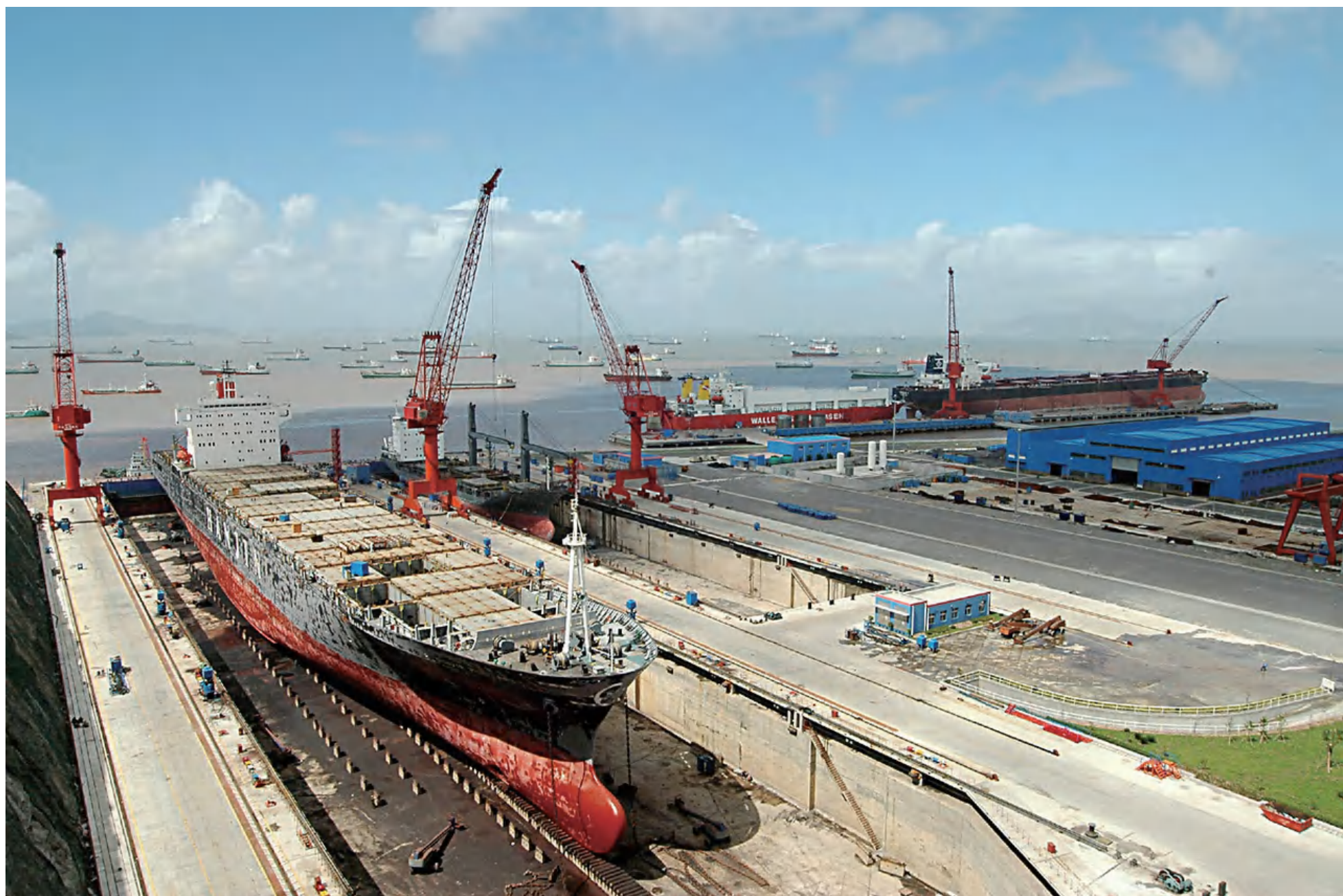
图4-16 万邦永跃30万吨级、10万吨级船坞及30万吨舾装码头
