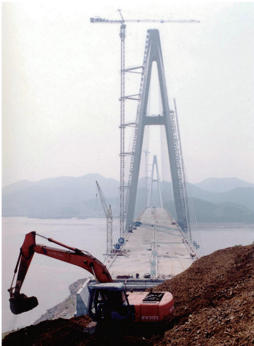
特-8 2003年建设中的桃夭门大桥
