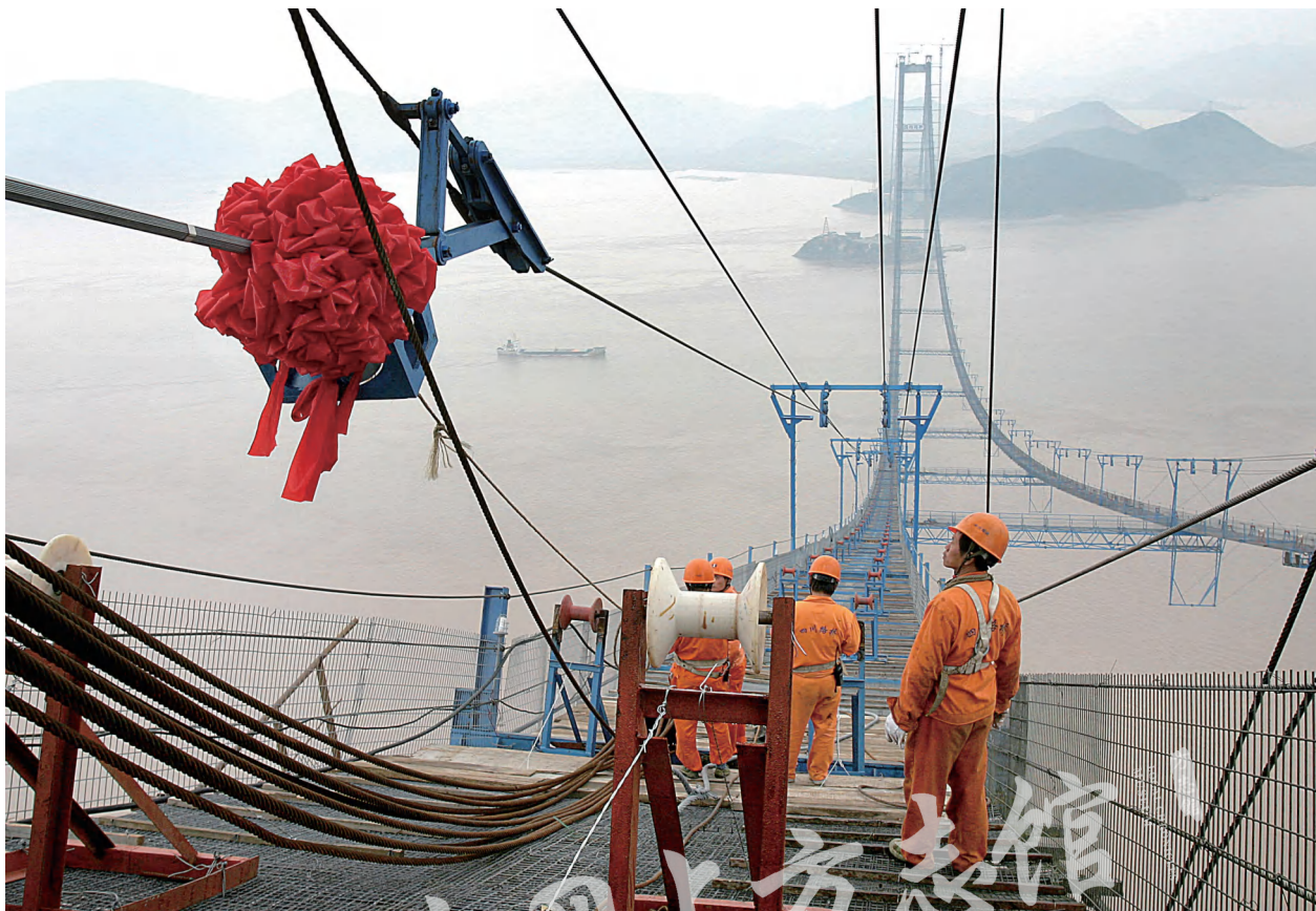
特-11 施工中的西堠门大桥
