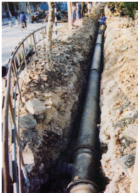
图3-55 敷设煤气管道（1989年）
