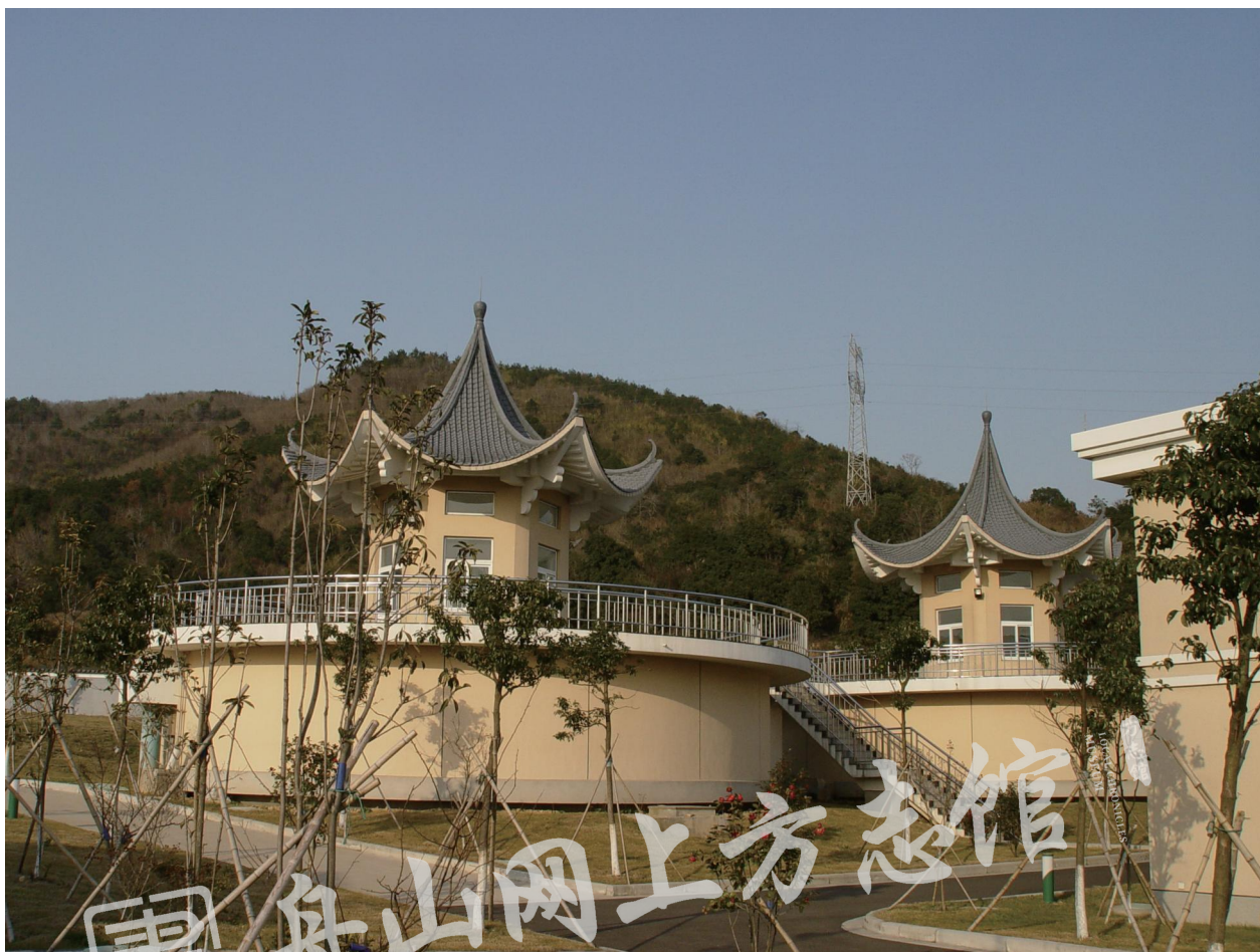
图3-50 市自来水公司净化水池
