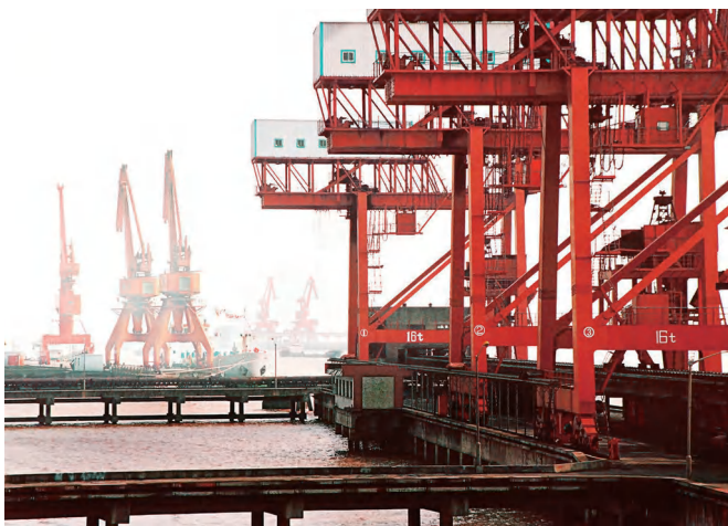
图3-42 老塘山港区二期工程
