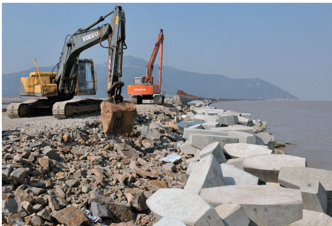
图3-45 定海海塘施工
