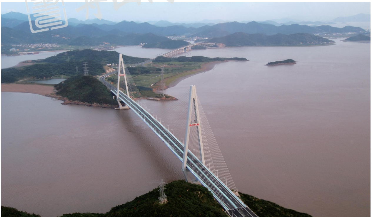
特-7 舟山跨海大桥
