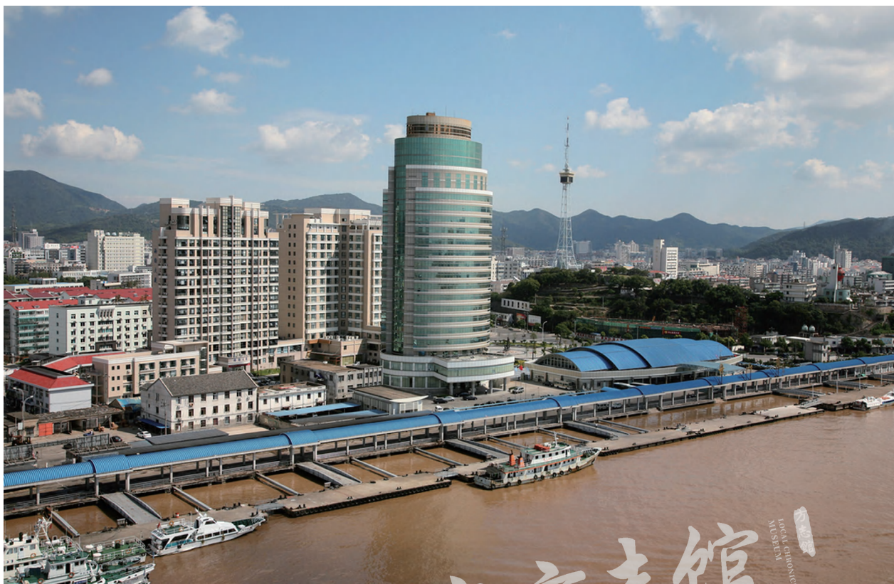
图3-1 改造后的定海客运码头
