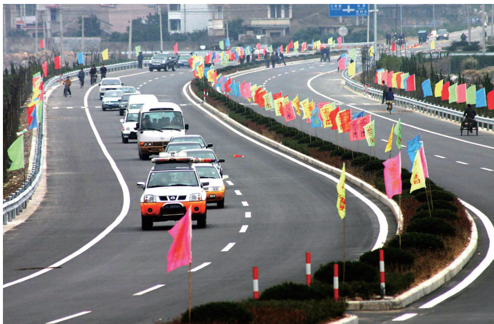
图3-15 建成后的沈白公路
