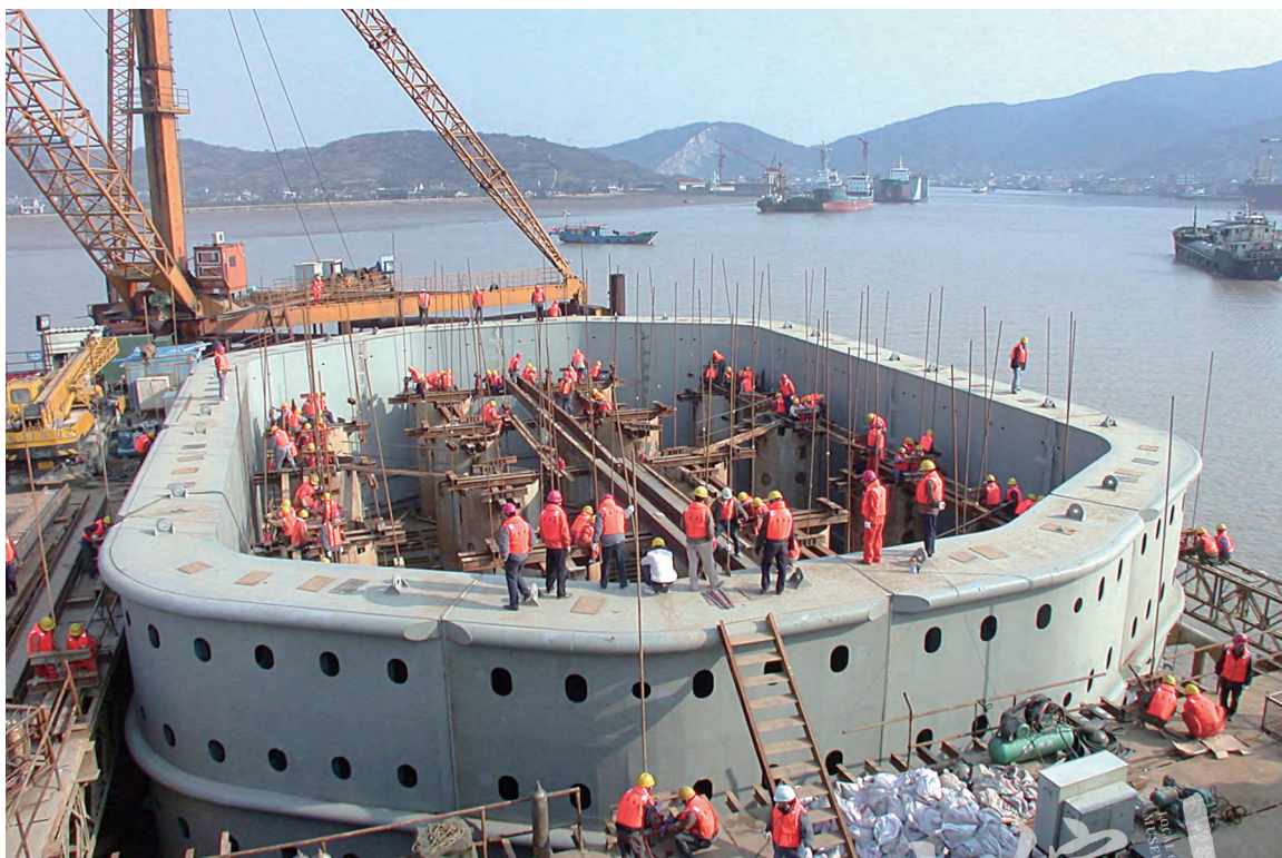
特-12 施工中的金塘大桥
