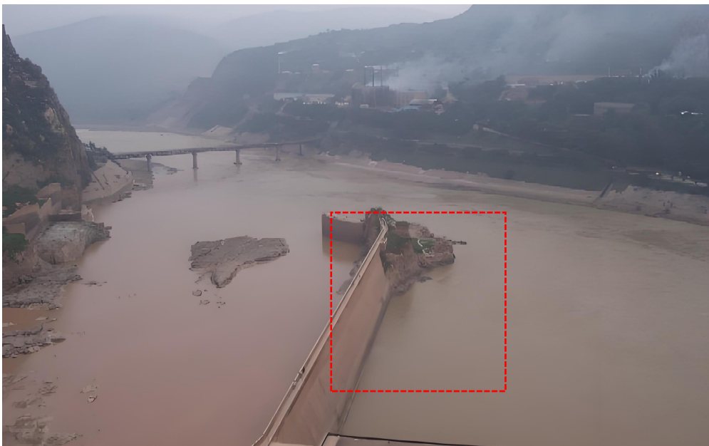
在传统村落段河流上游修建导流墙
