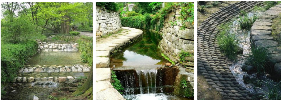
✓ 雨水排放结合村落地形，利用乡土石材形成自然排水沟
