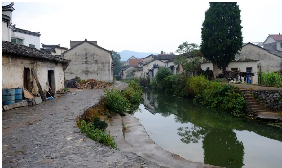
✗ 传统驳岸局部拆除，埠头被水泥覆盖，风貌较差
