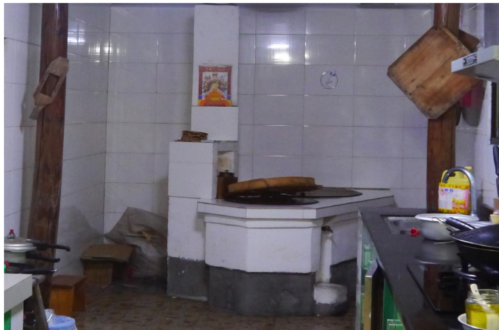
✗ 厨房设在木结构建筑内部，且未安装防火设施隔绝木构件
