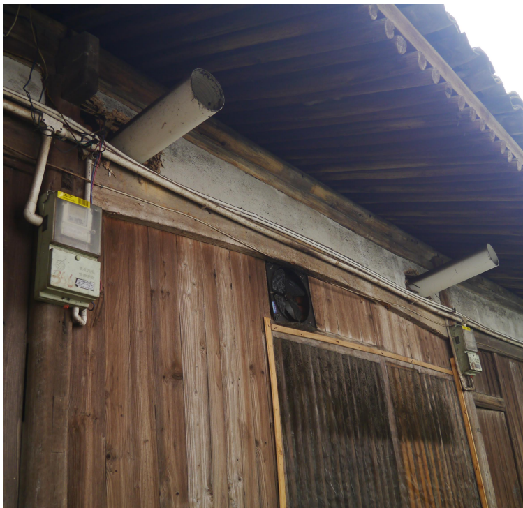
✘ 排气管道的样式破坏建筑立面风貌
